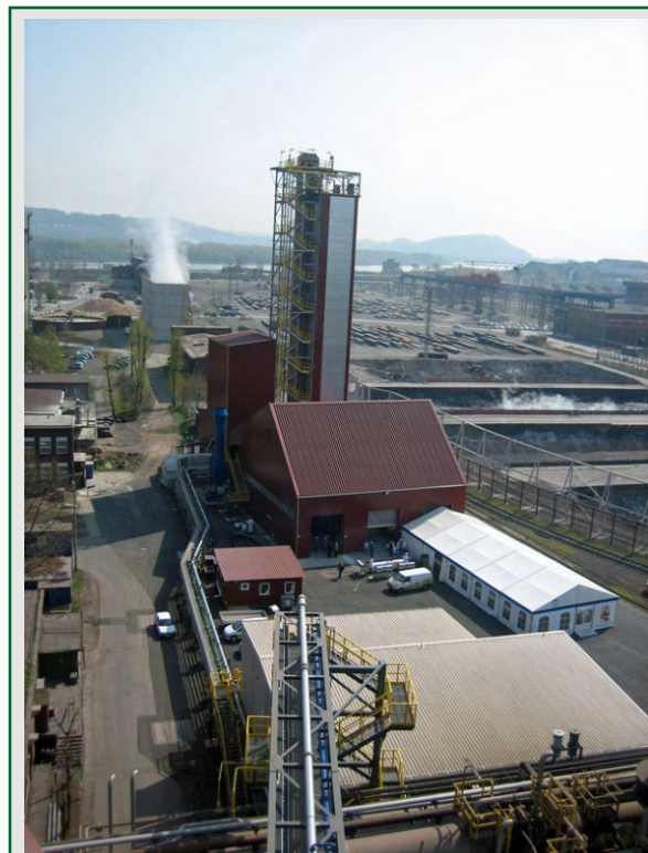
Бункер с пневмонасосом для промежуточной транспортировки
