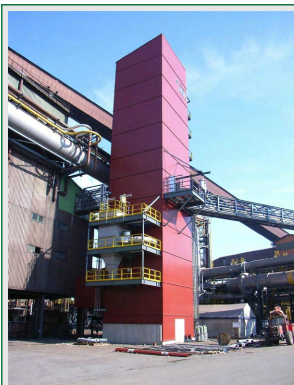
Установка вдувания производительностью 26 т/ч на доменной печи «А» в г. Линц, Австрия
