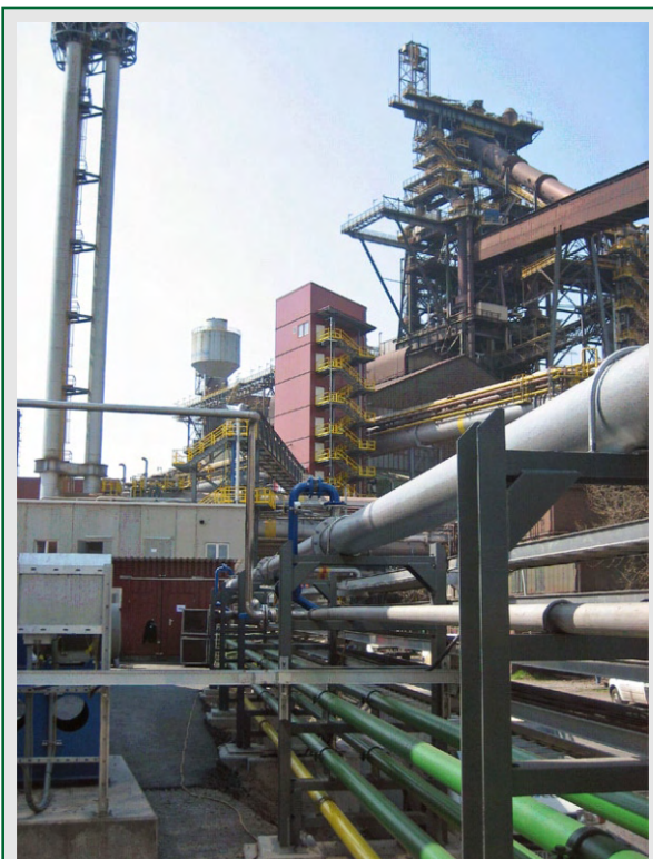
Промежуточный транспортный трубопровод между доменной печью и установкой ЕКОFOR (на заднем плане)
