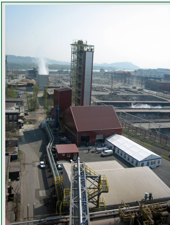
Бункер с пневмонасосом для промежуточной транспортировки
