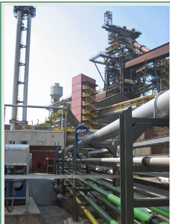
Промежуточный транспортный трубопровод между доменной печью и установкой ЕКОFOR (на заднем плане)
