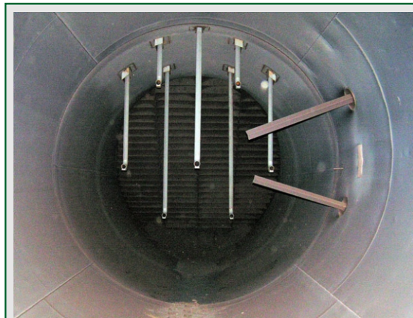
Инжекционные копия в канале отходящего газа
