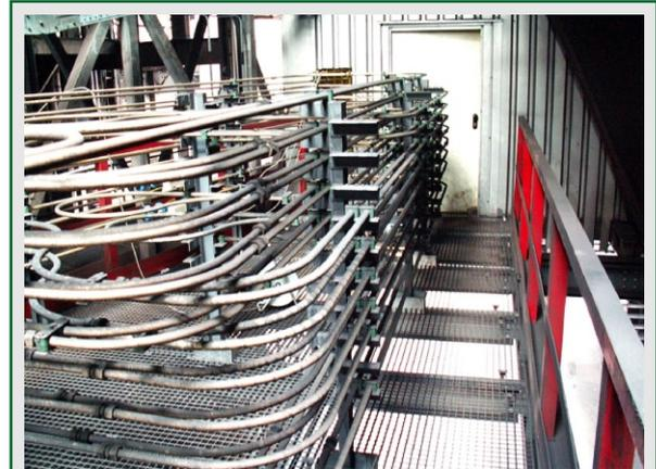
Пневмопроводы к доменной печи с линиями уравнивания гидравлического сопротивления
